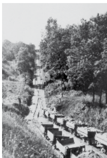
Werksbahn der Rheinisch-Westfälischen Kalkwerke AG zwischen dem Kalksteinbruch im Neandertal und der Berghöhe in Hochdahl. Der motorische Antrieb hierfür benutzte elektrischen Strom, der durch eine Turbinenanlage an der Düssel erzeugt wurde.
